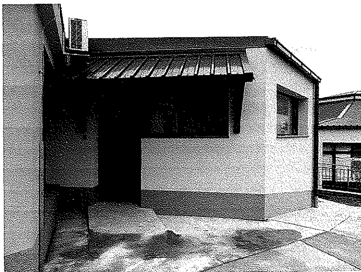
Nadstrešnica iznad jednog od ulaza u Vrtić
